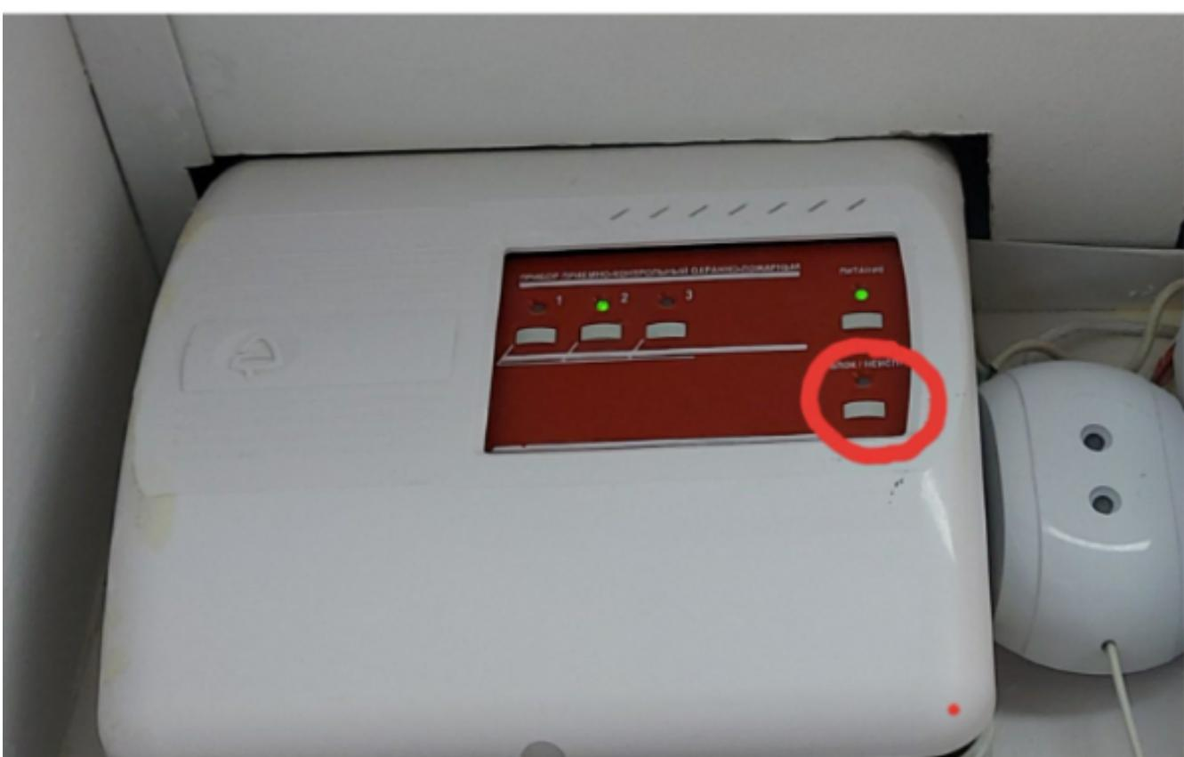
Также может сработать щиток снизу (называется «Гранит-3»): нажать один раз на красный датчик, чтобы он потух.
